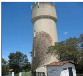
Château d'eau Cap de Hé
